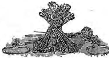
Fig. 423. — Chaîne d'arpenteur.
